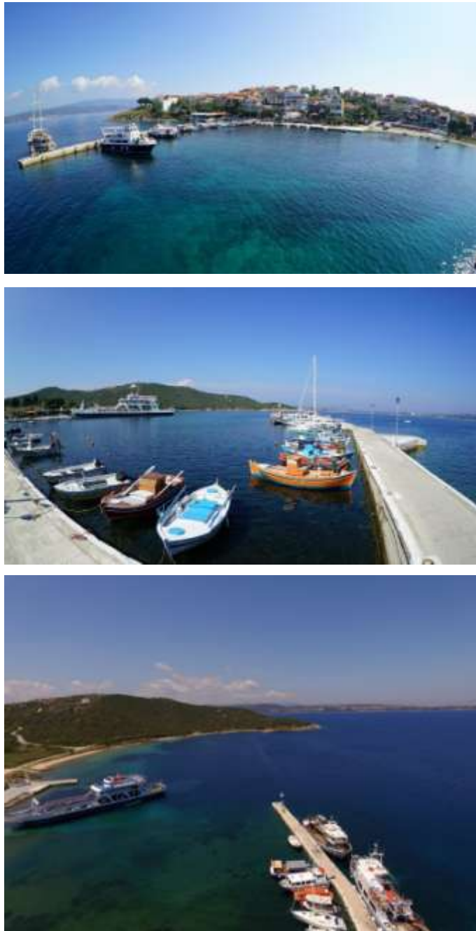
Εικόνα 9 Επιβατικός Λιμένας Αμμουλιανής
